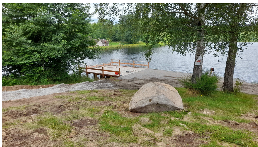
Ponton PMR en cours d'installation
