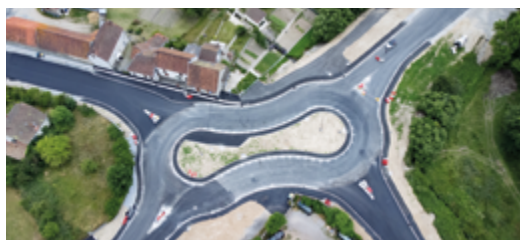
CRÉATION DE L'ÉCHANGEUR DU PRÉ CANTREZ À AUBUSSON
