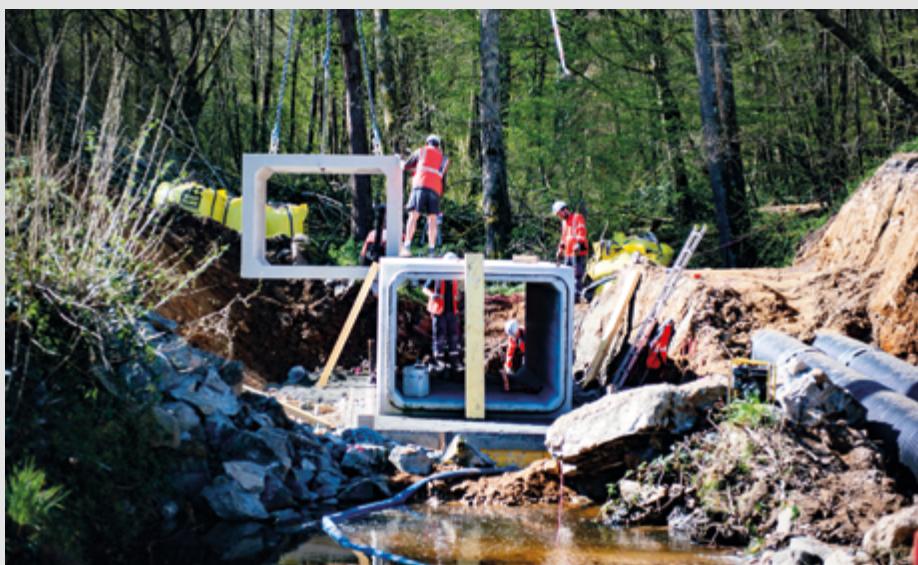
Reconstruction du pont de Cheveyron - Bonnat.
