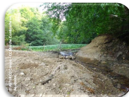
Effacement de digue d'étang
