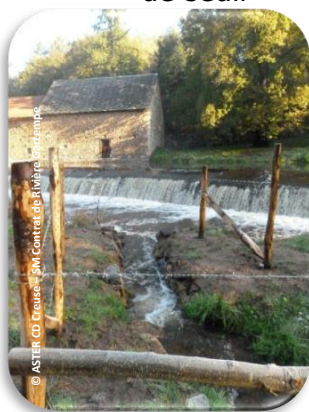
Canal de contournement de seuil
