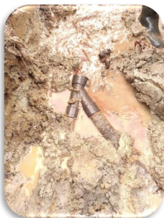
Retrait de drains
