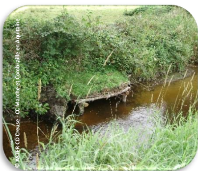
Création de sous berge
