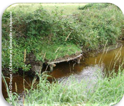
Création de sous berge
