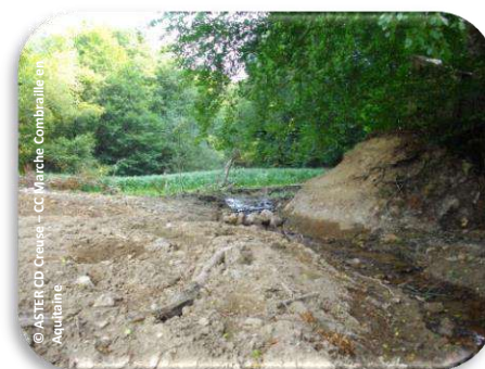
Effacement de digue d'étang
